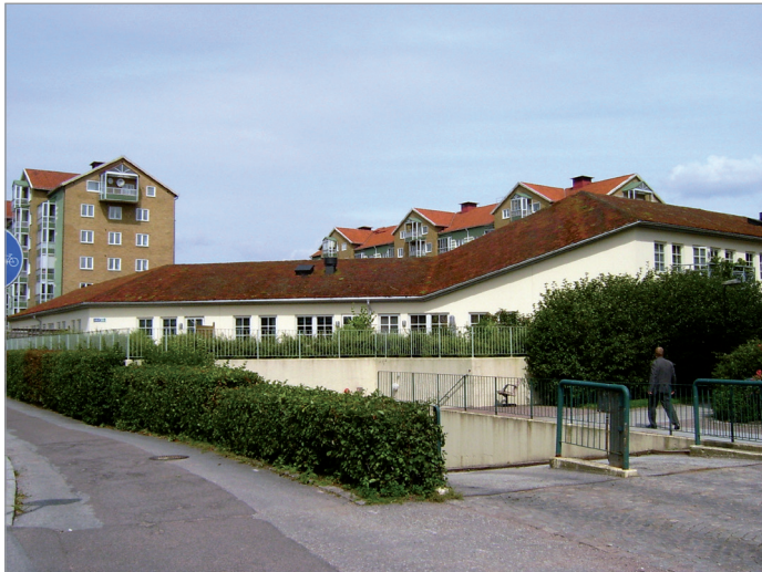
Figura 3 - Moderna copertura a verde estensivo a Malmö (Svezia)
