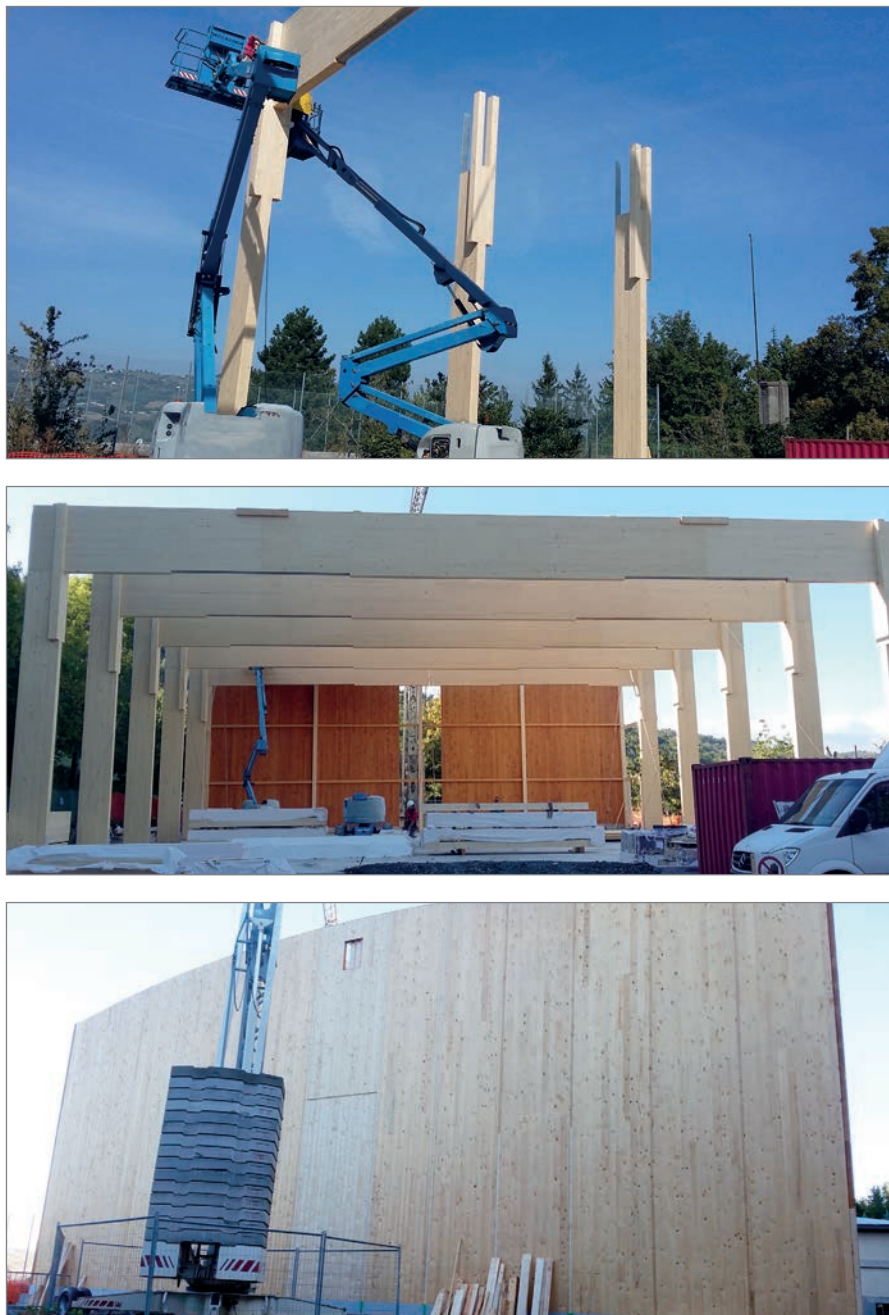
Figura 10.11. Palaestra Palagano: fasi di cantiere.
