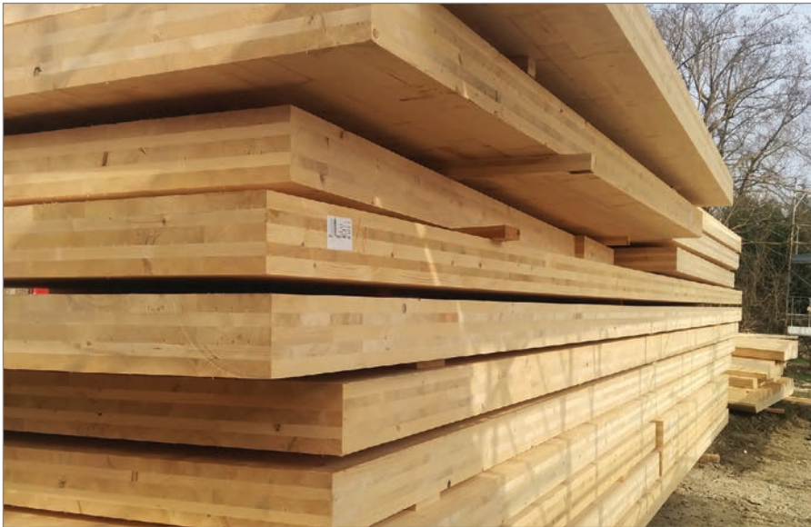
Figura 1.3. Area di stoccaggio dei pannelli X-Lam in cantiere.
