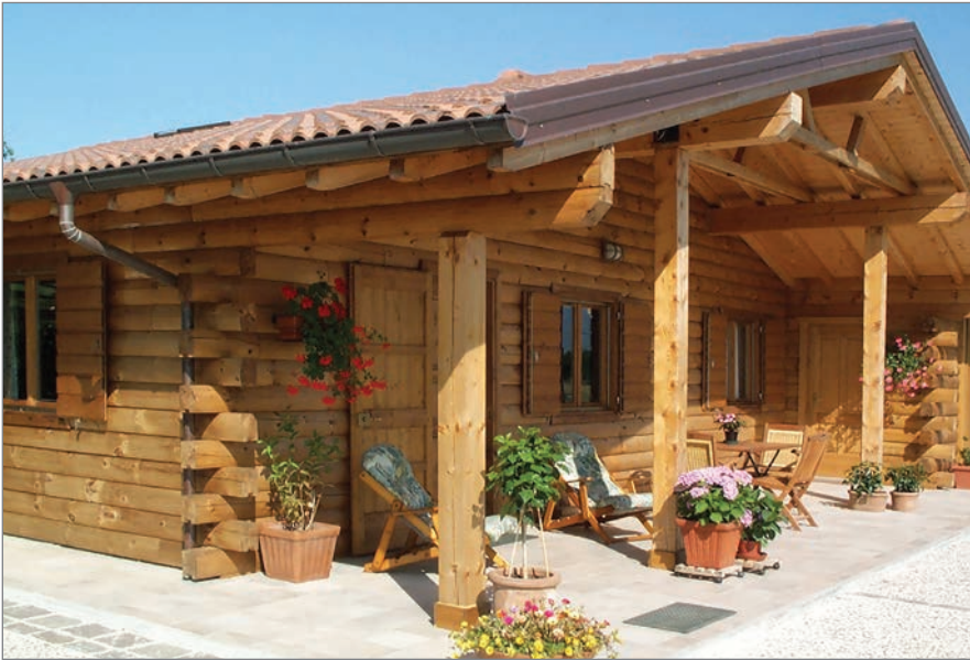
Figura 1.1. Esempio di costruzione Blockbau. [Fonte: Boraschi legnami].
