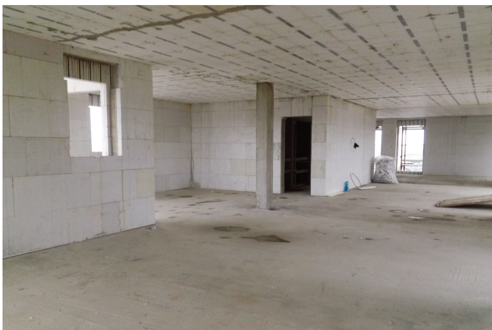
Figura 3.20 - Vista dell'interno di un edificio realizzato con sistemi ICF. Si notino gli spazi liberi interni e la presenza di un pilastro.
