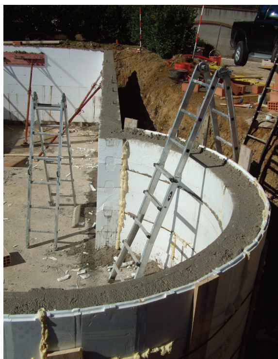
Figura 11.3 - Lato curvilineo della piscina dopo il getto.
