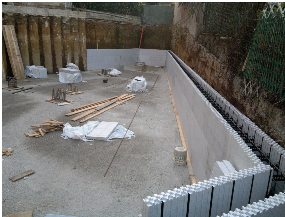
Figura 2.20 - La foto rappresenta una parete controterra di particolare estensione e di notevole impegno statico (quota sbancamento -6,00 m), realizzata mediante casseri ICF. Si noti sulla sinistra la presenza di una paratia di pali trivellati uniti alle pareti ICF.
