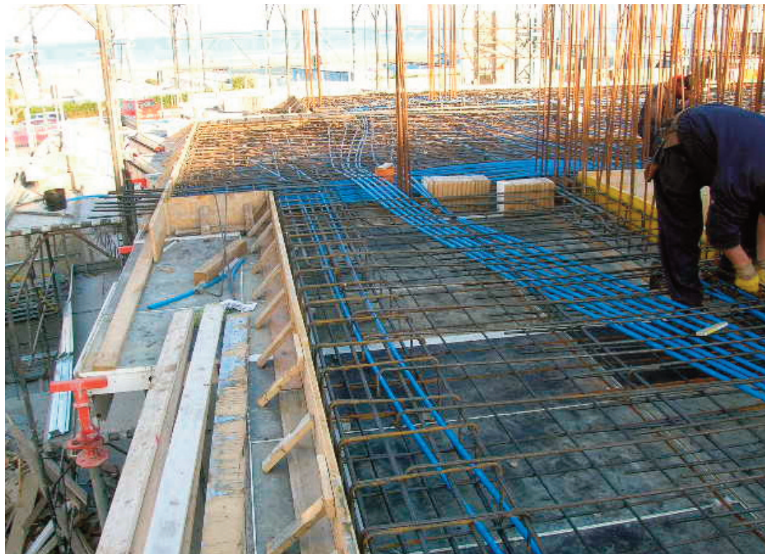
Figura 2.21 - La foto rappresenta un impalcato a cavi post-tesi.
