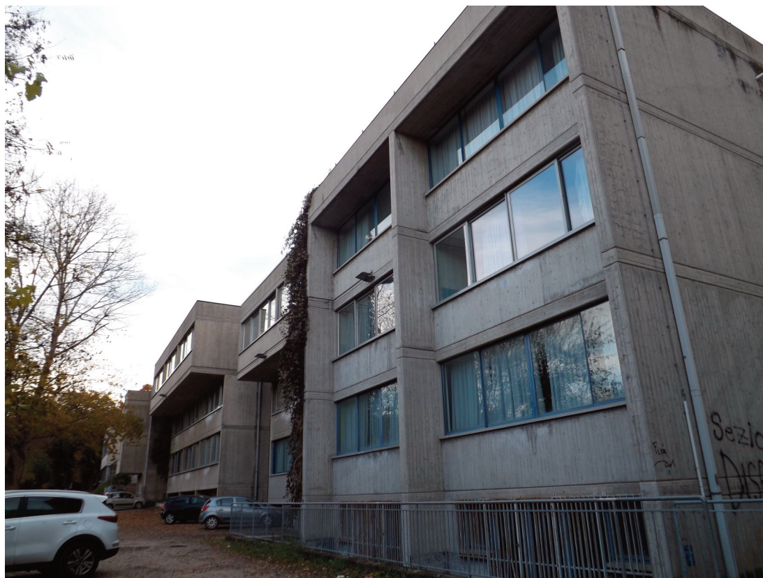
Figura 1.1 - Plesso scolastico a pareti portanti in cemento armato realizzate in opera di spessore 20 cm sito a Novafeltria (RN).
