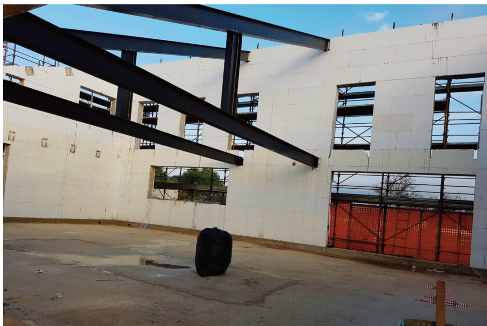
Figura 2.23 - L'immagine rappresenta una trave metallica di grande luce ancorata a pareti ICF con funzione di collegamento e di sostegno di una copertura leggera.
