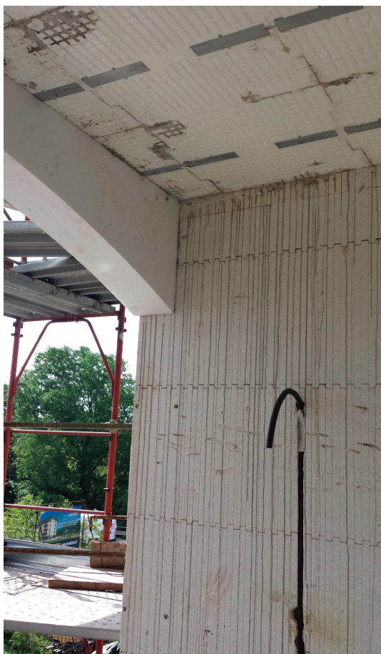
Figura 3.19 - Realizzazione di volta mediante pannello in polistirene sagomato applicato a colla sui pannelli ICF. Si noti anche la predisposizione di un tubo corrugato.
