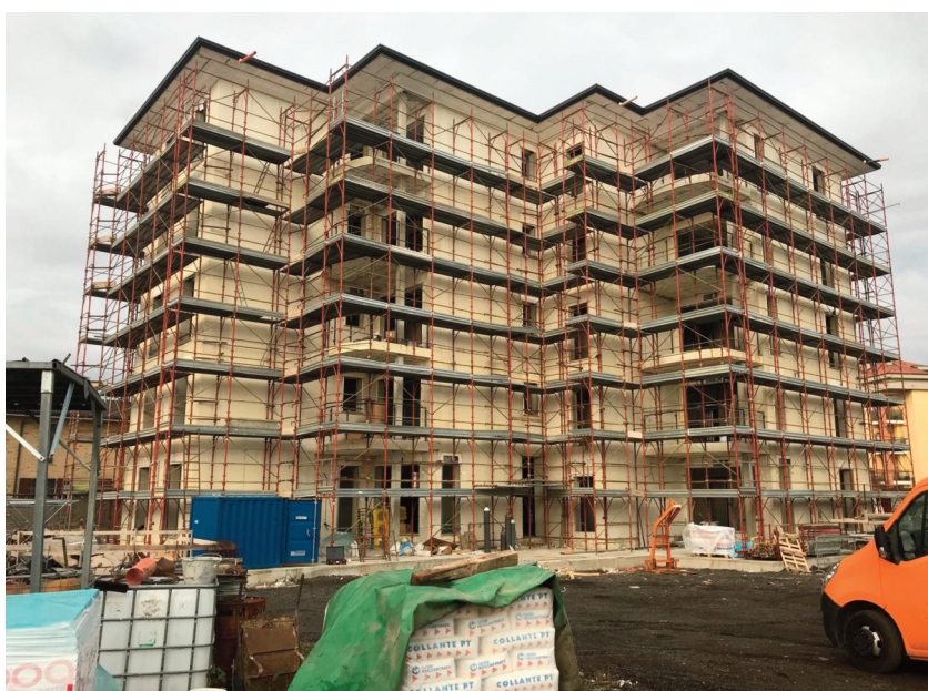
Figura 18.1 - Vista della palazzina in corso di costruzione.
