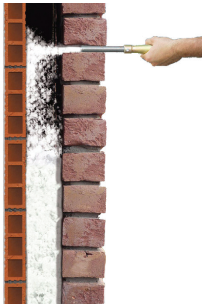
Figura 2.6 - Insufflaggio dell'intercapedine
